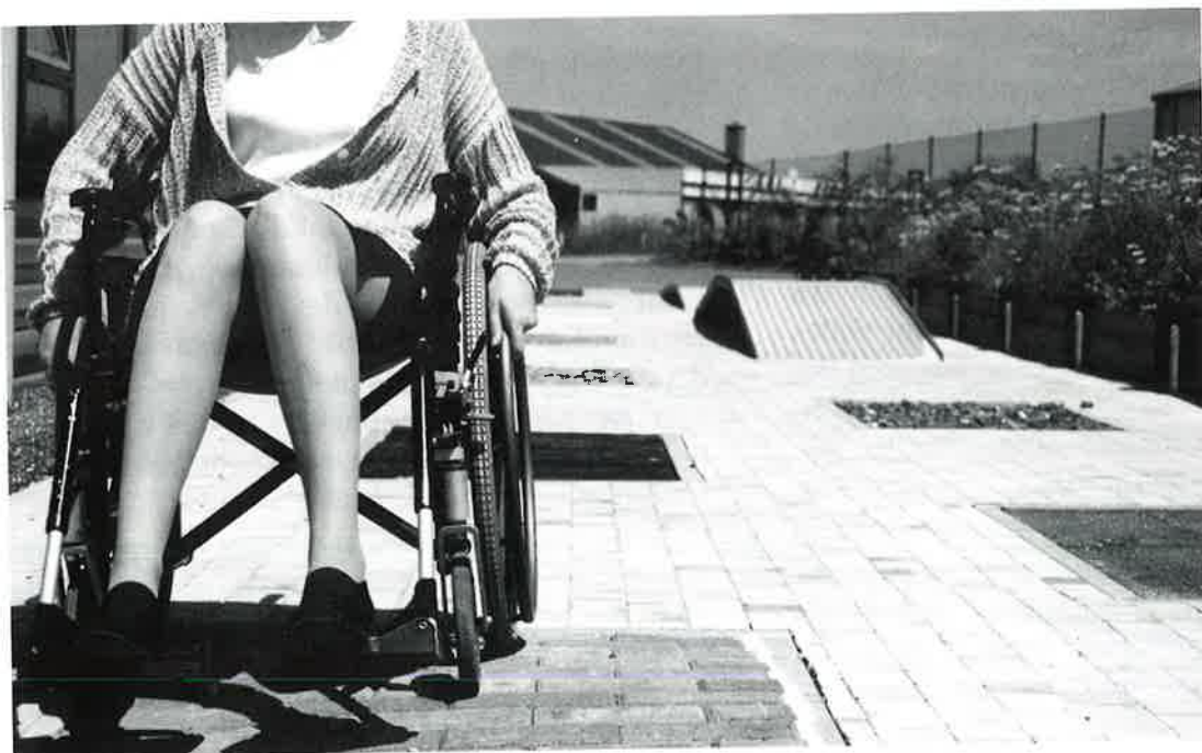
Un revêtement en pavés non-glissant. A l'arrière-plan : billes de chemin de fer, dos d'âne, plans inclinés,...
